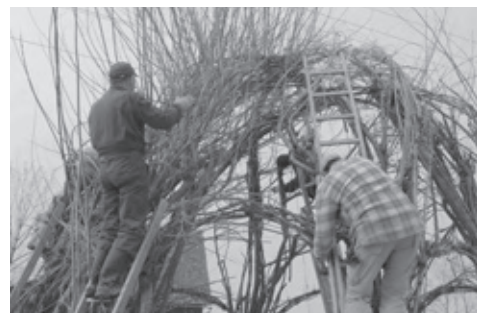
Der NV Horgen hält das vor rund 10 Jahren erstellte Weidenhaus jährlich in Schuss. Die schnell wachsenden Triebe müssen regelmässig zurückgeschnitten und in Form gebogen werden. (Bild: NV Horgen)
