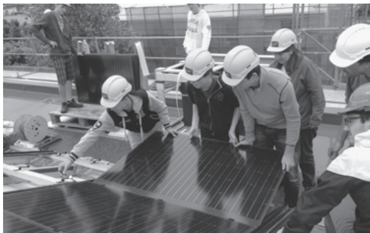
Schüler in Burgdorf beim Einsetzen von Solarmodulen auf dem Schulhausdach. (Bild: www.jugendsolar.ch)
