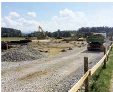
Direkt neben einem bestehenden Feldweg: Die neu erstellte Deponiezufahrt. (Bild: Andreas Hasler)
