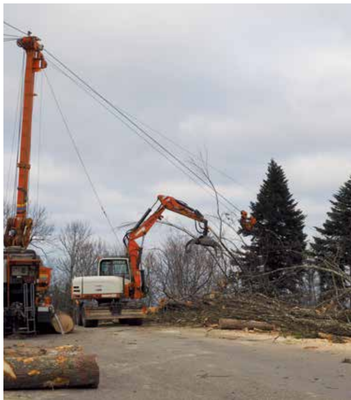
Ist der Seilkran einmal installiert, befördert er innert kurzer Zeit erstaunliche Mengen an Holz zum Sammelplatz. (Bild: Susanna Hübscher)
