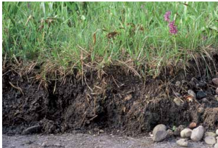
Orchis morio (das Kleine Knabenkraut) mit Dachprofil des Seewasserwerks Moos in Wollishofen. (Bild: Stephan Brenneisen)
