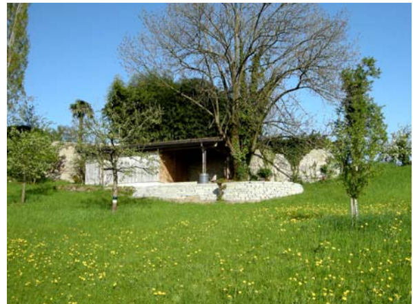
Die neue und vom NVMU mitfinanzierte Natursteinmauer im Lattenberg bei der Hütte des Nachbarvereins AGN Stäfa.
